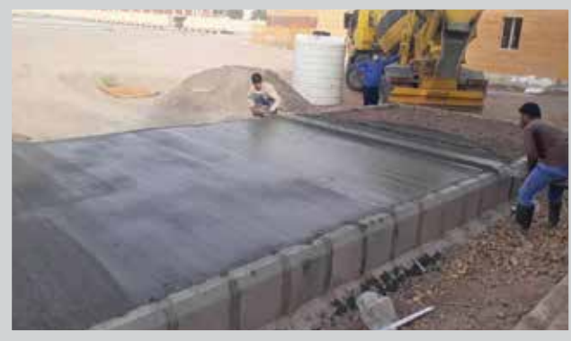
ساخت سکو برای کانکس اورژانس هوایی
