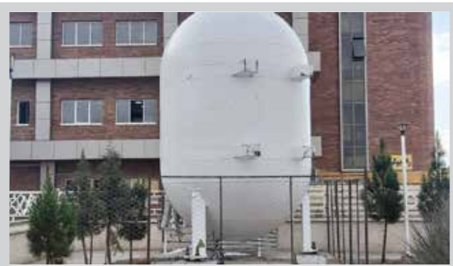
خرید، تحویل و نصب مخزن اکسیژن ۲۰ تنی
