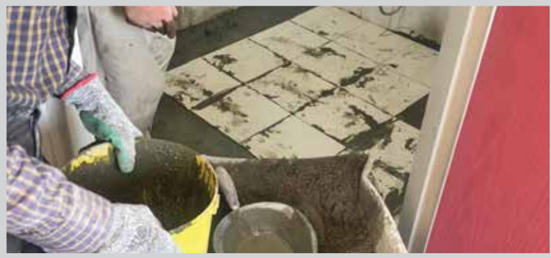
تعمیر و اصلاح ۴ چشمه سرویس بهداشتی
