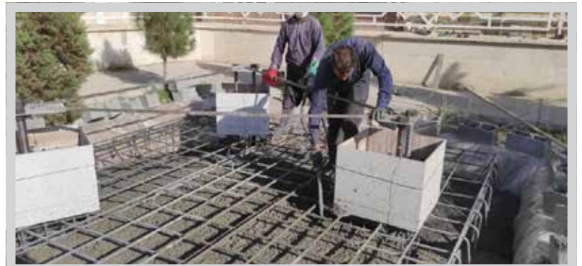
فونداسیون و بتن ریزی مخزن اکسیژن ساز ۲۰ تنی
