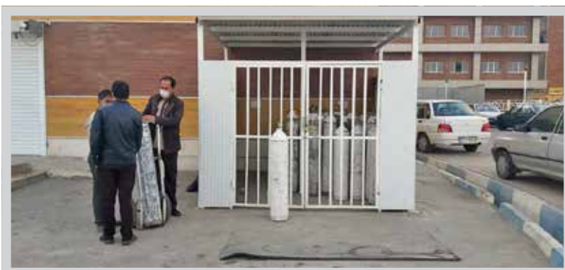
ساخت محفظه نگهداری از مخازن اکسیژن قابل حمل
