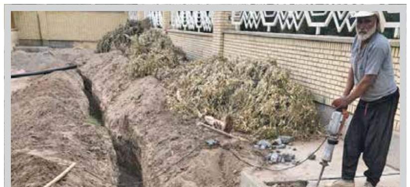
جابجایی تأسیسات زیربنایی گاز و آب برای ساخت سوله ها
