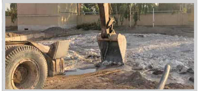
خاکبرداری و شفته ریزی سوله آموزشی به مترائز ۵۰۰ متر
