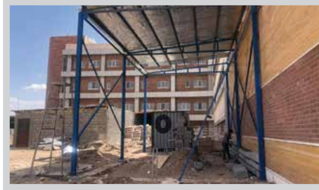
شروع ساخت ساختمان اکسیژن ساز
