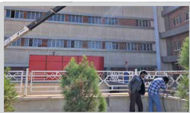
ساخت و نصب خرپا برای نصب لوله‌های مسی مخزن اکسیژن
