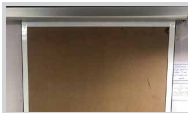
نصب درب ضد اشعه برای بخش سی تی اسکن
