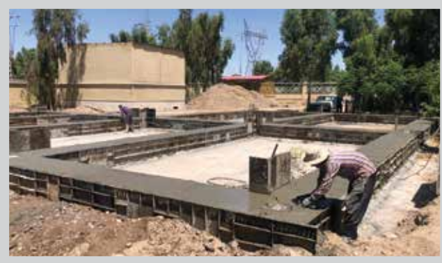
فونداسیون و بتن ریزی برای سوله انبار دارویی به مترائز ۴۰۰ متر
