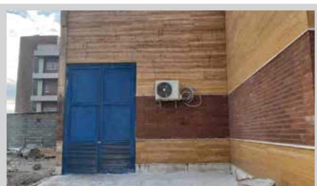
احداث ساختمان اکسیژن‌ساز
