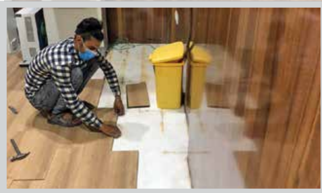
اصلاح کفپوش و نصب پارکت برای بخش ماموگرافی
