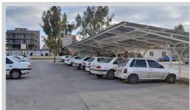
احداث پارکینگ مسقف برای پرسنل
