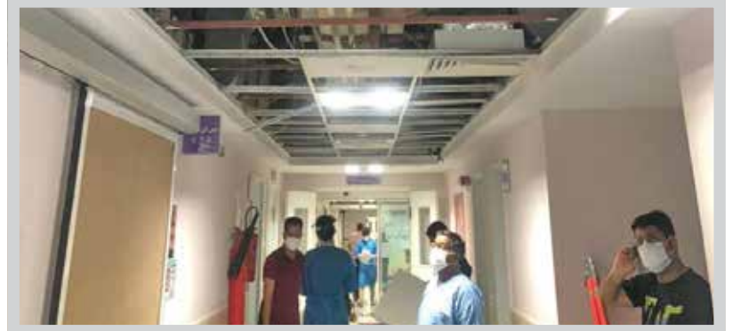
اصلاح سقف کلیک راهرو بخش رادیولوژی
