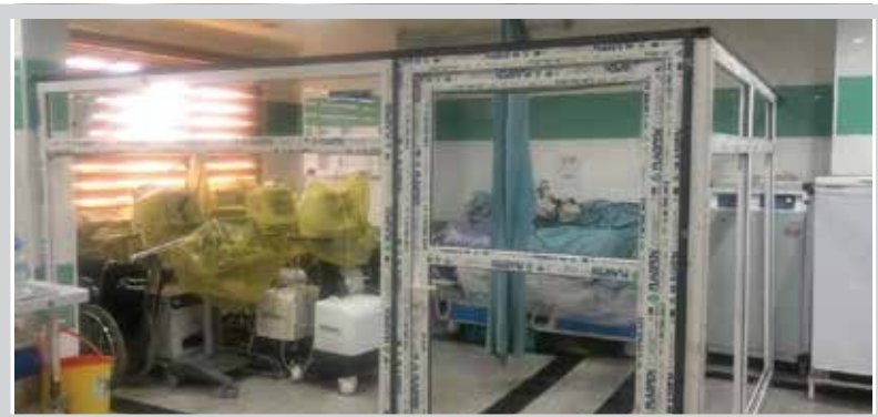
پارتیشن بندی و ساخت انبار تجهیزات برای بخش ICU
